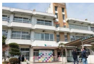
空き校舎を活用した 陸前高田サテライト
